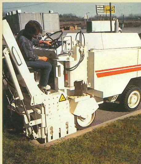
縁石ギリギリでの切削状況
