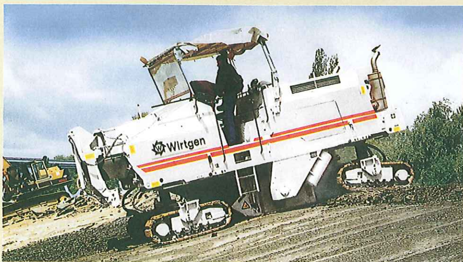
貯水ダムの表層からはぎ取られた廃材はプラントでリサイクルされる
