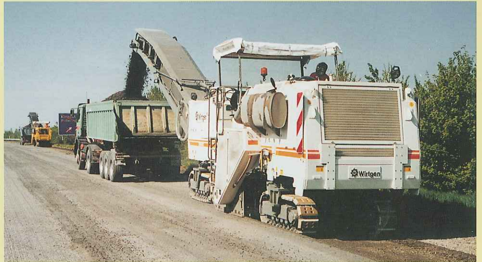
前方積み込み方式で切削作業を行います。切削された材料は粒状化され、2段階構成のコンベア・システムによって、直接トラックへ積み込まれます。
