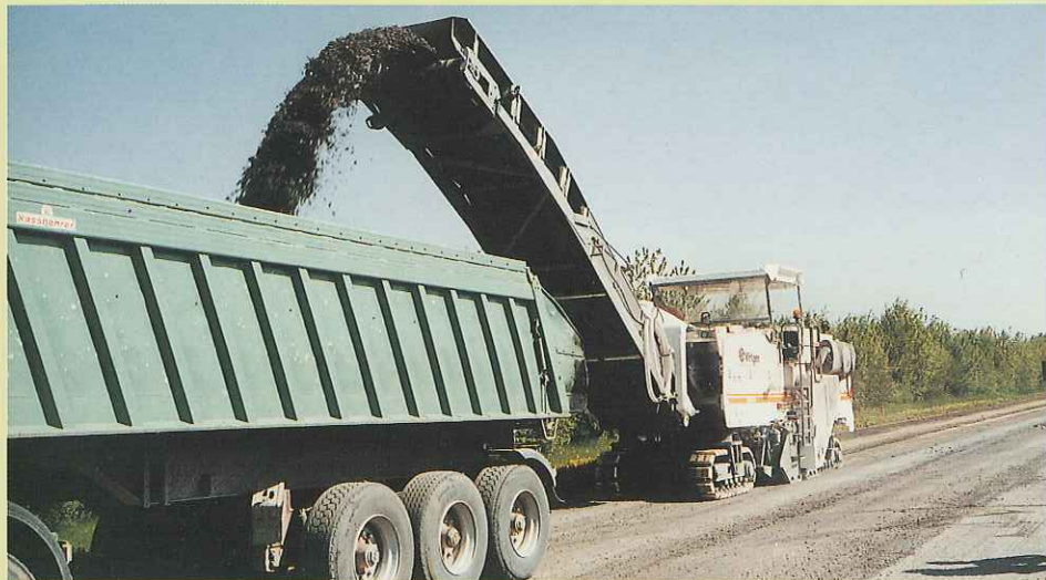
積み込みベルト・コンベアの長さゆとりがあるため、大型セミトレーラーのような広い荷台全体にも万遍なく切削された骨材（RAP）を積み込むことが出来ます。
