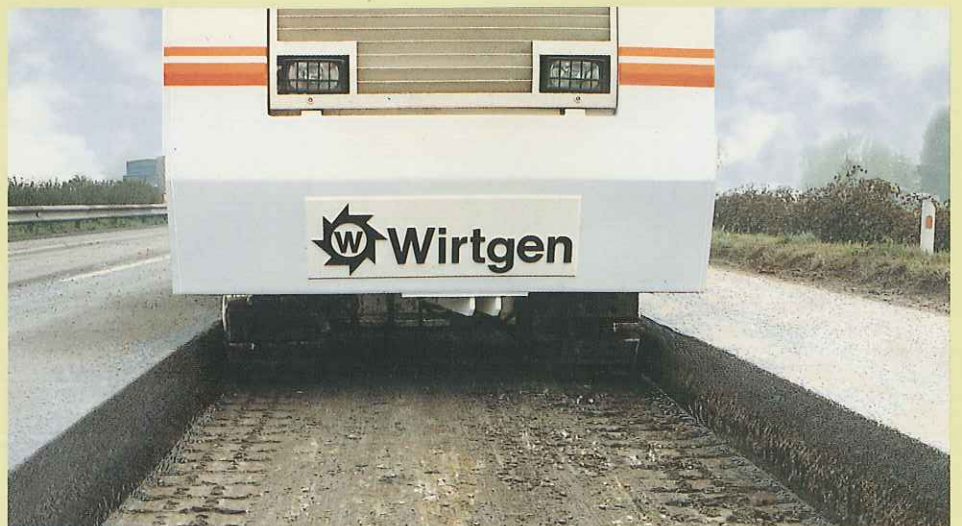
全アスファルト層が、300mmの深さで、しかもシングル・パスの作業で切削されます。
