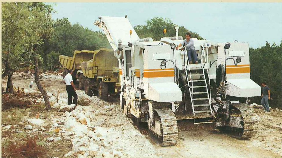
3500SM:アメリカ(テキサス州 サンアントニオ)の道路建設現場
