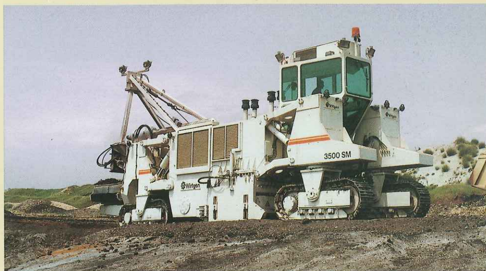
右端の壁に接して切削中の3500SM.
