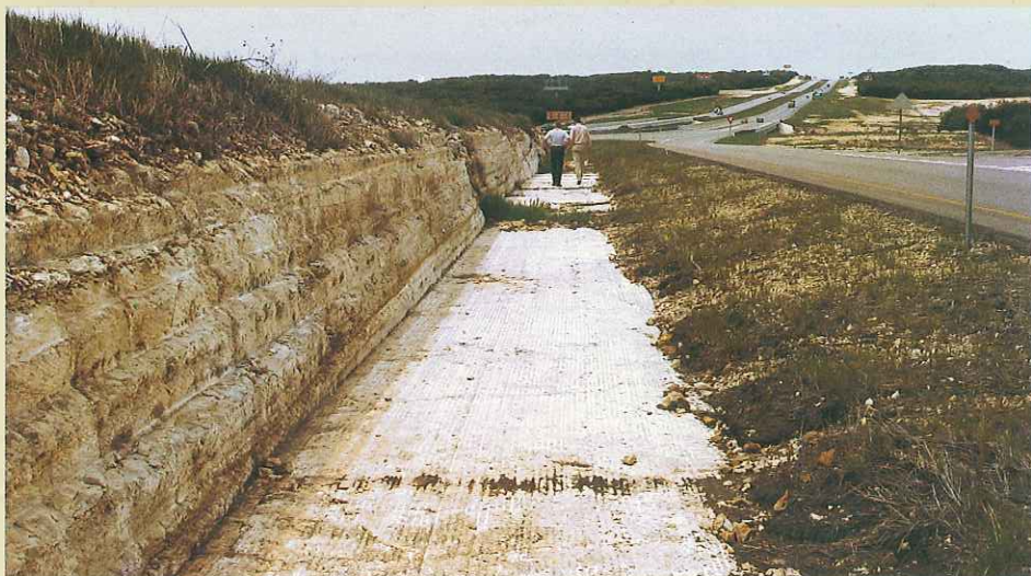
3500SM. の作業が終了しました。完全な路床をつくっています。ステップのついた法面ときれいな切削路面に注意して下さい。
